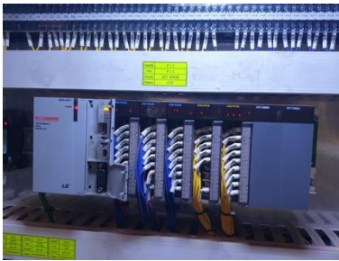
단종 PLC 패널 → XGT PLC 개조
